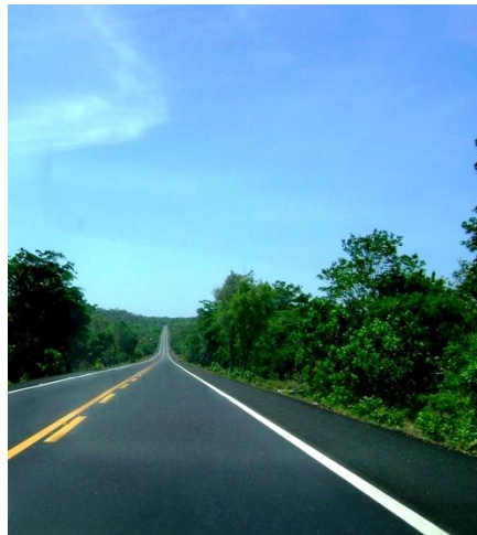
Figura 12 - Trecho da BR 316, com ótima condição asfáltica
