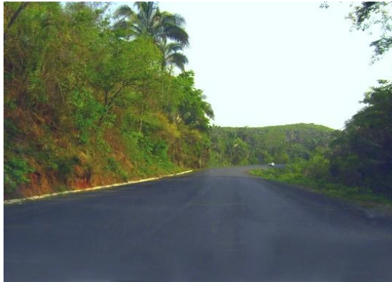
Figura 13 - Trecho da BR-316 sem sinalização
