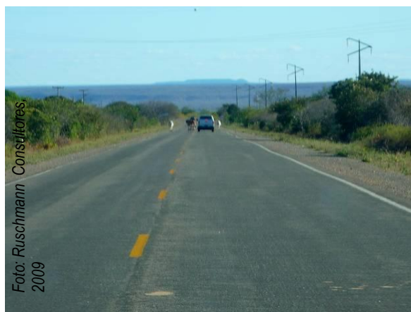
Figura 92. Trecho da BR - 020 próximo a São João do Piauí
