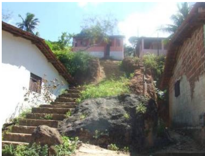
FIGURA 15. Edificações em área de Alta Declividade com Acesso Precário - Sen. Georgino Avelino/RN.
