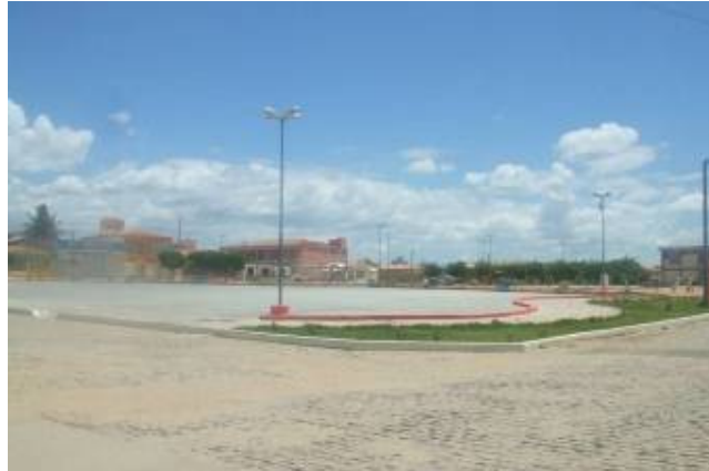
FIGURA 63. Praça sem a presença de vegetação e sem acessibilidade – Parelhas.
