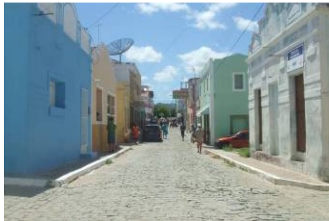
FIGURA 51. Passeio público com largura inferior a 50 cm, não permitido a acessibilidade – Acari.
