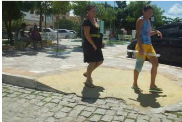
FIGURA 52. Passeio público com rampas sem atender as normas de acessibilidade – Acari.
