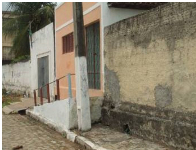
FIGURA 16. Implantação errada de equipamento urbano no passeio público - São Gonçalo do Amarante/RN.
