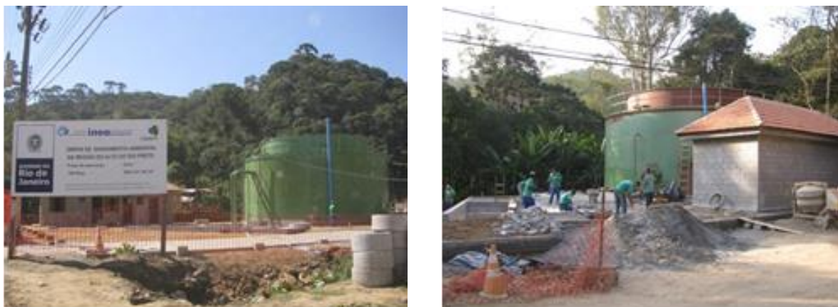
Figura 30 – Construção das ETES de Visconde de Mauá e de Maringá. Fonte: IBAM, 2010
