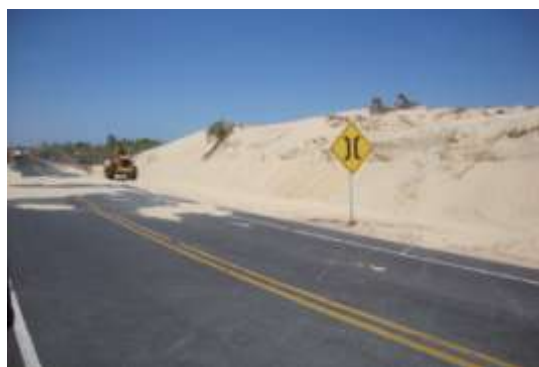
FIGURA 18 - TRABALHO DE RETIRADA DA AREIA DA ESTRADA PELO AVANÇO DA DUNA NO MUNICÍPIO DE LUIS CORREIA
