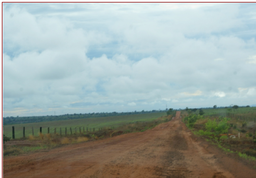
Figura 2.4.1.1.2 Trecho de Estrada em Cocalinho
