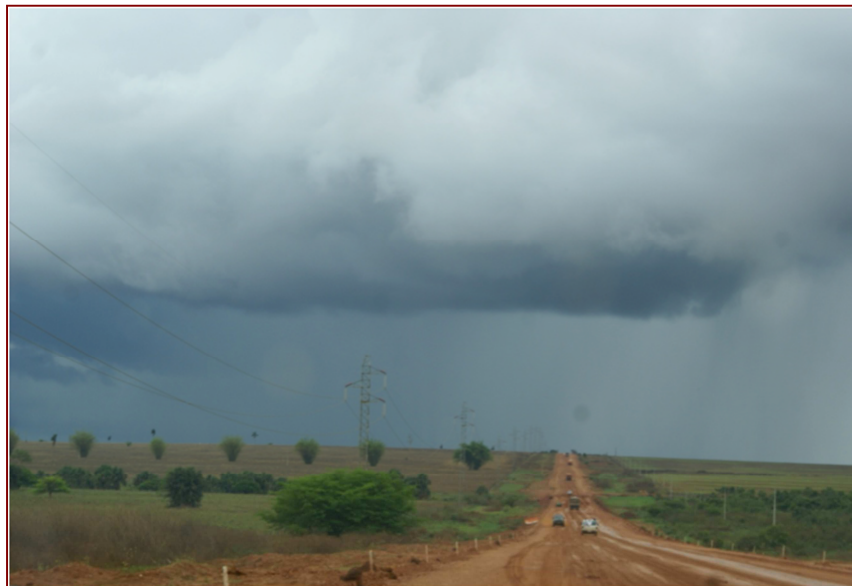
Figura 2.4.1.1.3 Trecho de Estrada em Confresa (MT-158)
