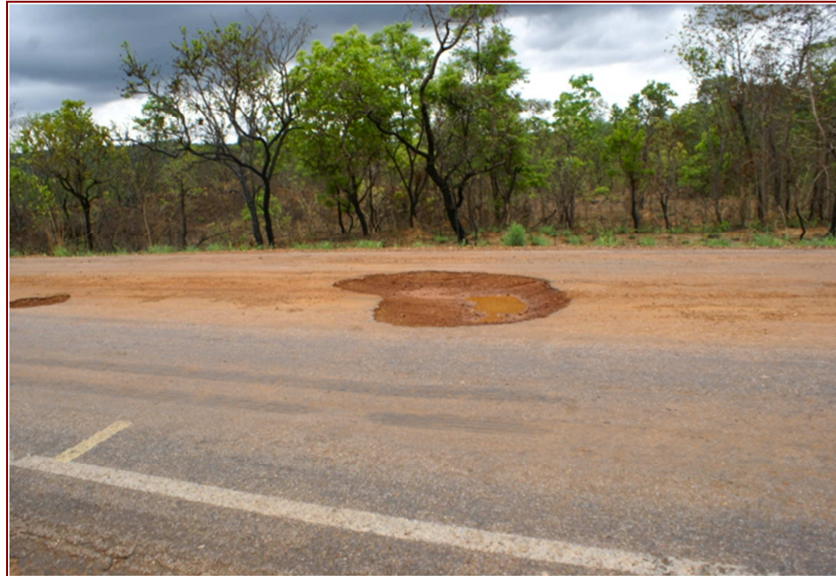
Figura 2.4.1.1.1 Trecho de Estrada em Água Boa
