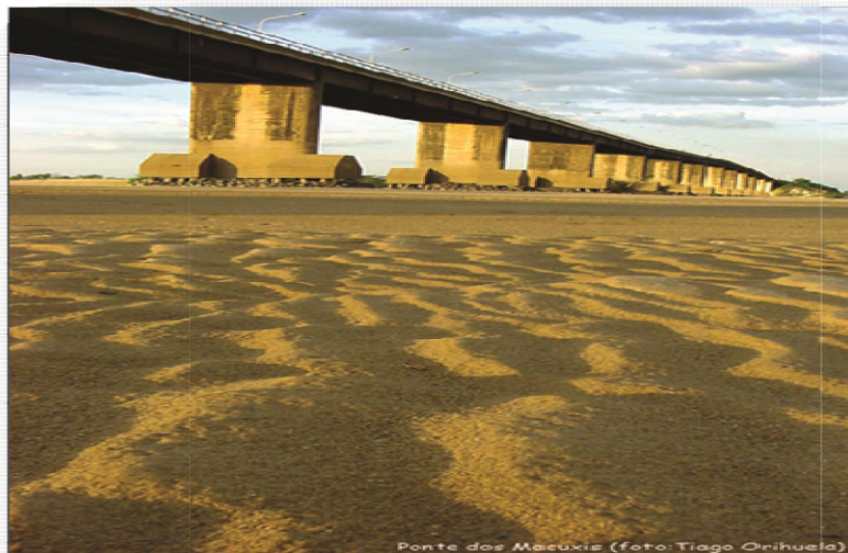
Figura 35 – Ponte dos Macuxis
